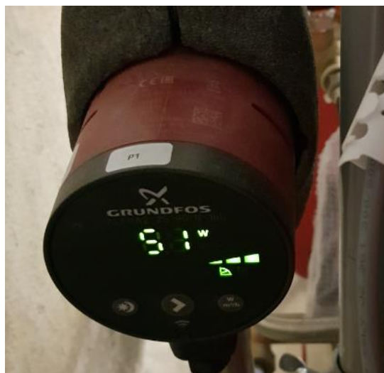
Figur 10. Cirkulationspump på VVC-krets.
