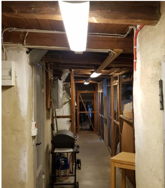
Figur 4. Vindsutrymme med förråd.
