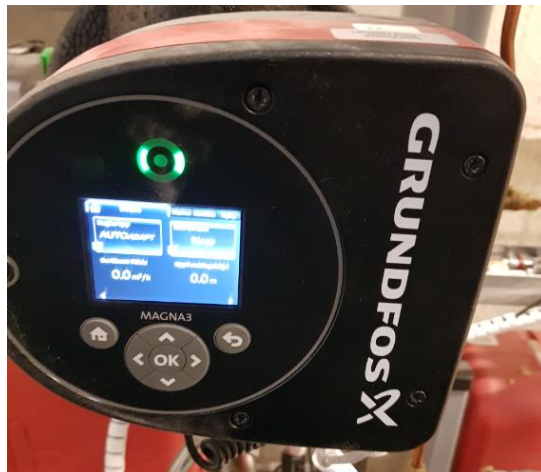
Figur 8. Cirkulationspump på VS-krets.
